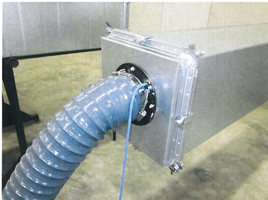
Anschluss Prüfschlauch zur Druckaufgabe
